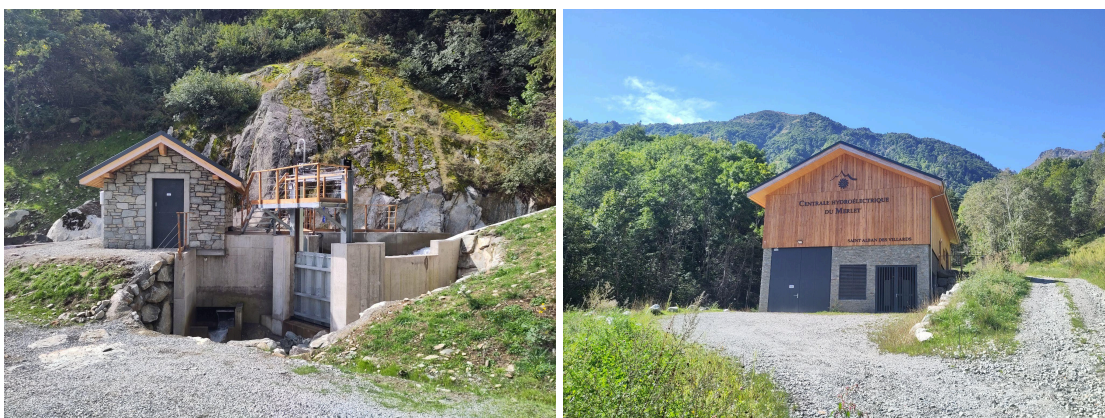
Centrale du Merlet située sur la commune de Saint Alban des Villards, dans le département de la Savoie, dernière centrale d'Hydrocop mise en service en septembre 2024.
